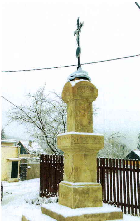
2/ Řepčice - stav po celkové rekonstrukci
